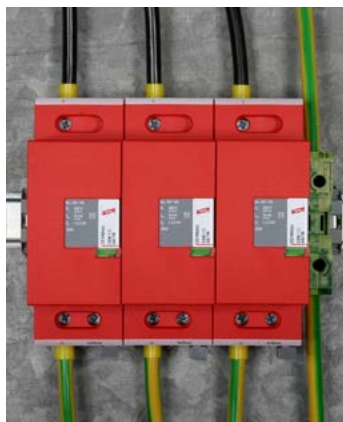
Befestigung durch einfaches Aufrasten auf einer Hutschiene.
