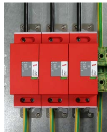
Befestigung auf einer Montageplatte mit 2 Befestigungsbügeln, die im Lieferumfang enthalten sind.
