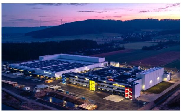
DEHN setzt sich seit Jahren intensiv mit Nachhaltigkeit auseinander, was sich auch in der Architektur der Gebäude widerspiegelt - zum Beispiel durch Solarenergie, Gründach, Temperierung mittels Betonkernaktivierung. Bild: DEHN SE
